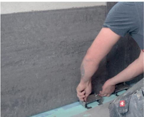
Drehen Sie an den Stellschrauben, um die Fliese genau anzupassen.
