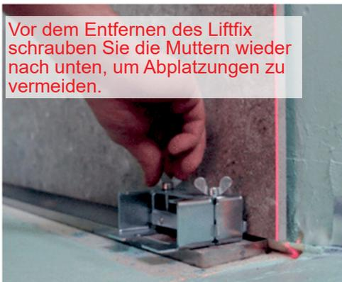
Vor dem Entfernen des Liftfix schrauben Sie die Muttern wieder nach unten, um Abplatzungen zu vermeiden.
