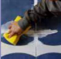
3. Nach ca. 15 min den Fugenfärber mit Wasser und einem Spezialschwamm von den Fliesen wischen.
