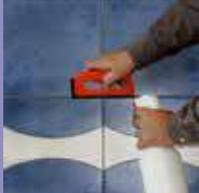
1. Vor Arbeitsbeginn Fugen von Verschmutzungen und Beschichtungen reinigen.
