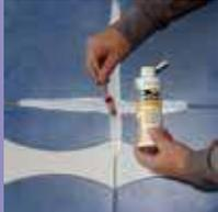
2. Fugenfärber in die trockene Fuge mit einem Schwamm oder einer kleinen Bürste einarbeiten.
