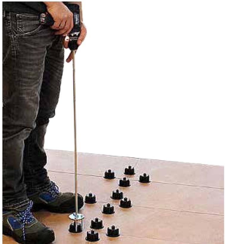
Levelmac® Drehstab 700 mm zum Abdrehen der Zughauben am Boden in Sekundenschnelle.
