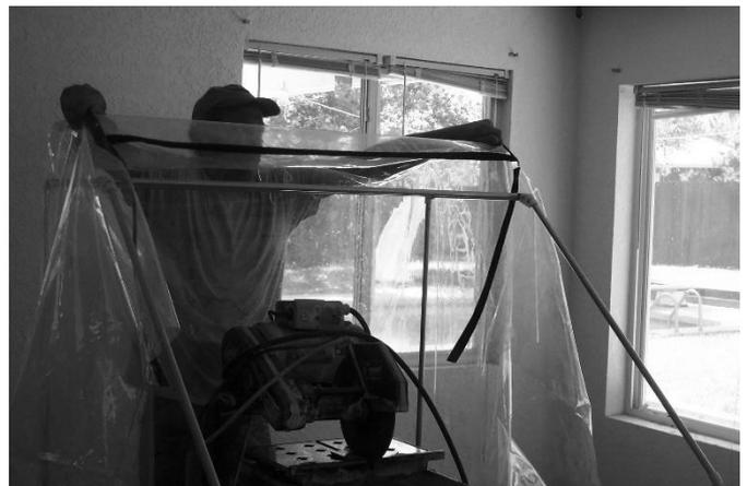
8) Reißverschluß an der Schutzhaube schließen und dann die Plane von hinten über das Gestell ziehen.
