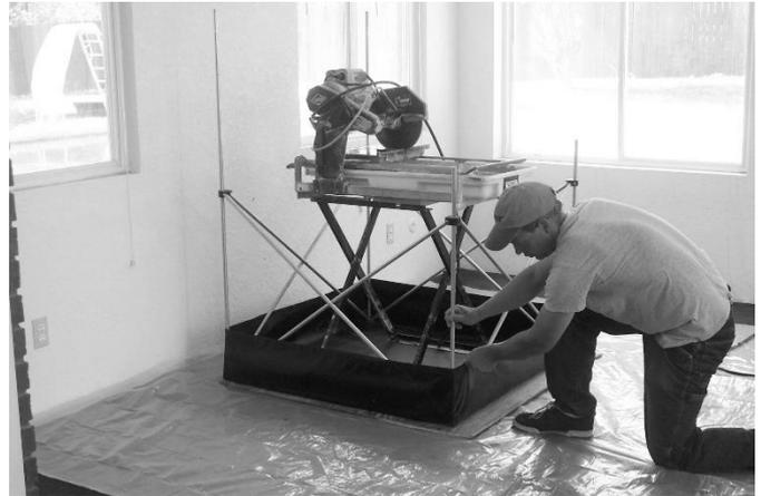
6) Straffen Sie die Bodenwanne indem Sie die Füße des Rahmens bis in die Ecken der Wanne ziehen. Zur Verbesserung der Standfestigkeit und Haltbarkeit der Bodenwanne legen Sie die 4 beiliegenden Gummiunterlagen zwischen Füße und Bodenwanne.
