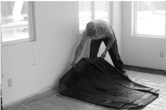
3) Legen Sie die Bodenwanne der Nassschneidekabine auf den Boden oder die Sperrholzplatte.
